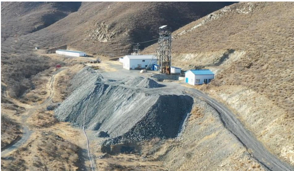
照片1-4 风井（FJ2）工业场地
