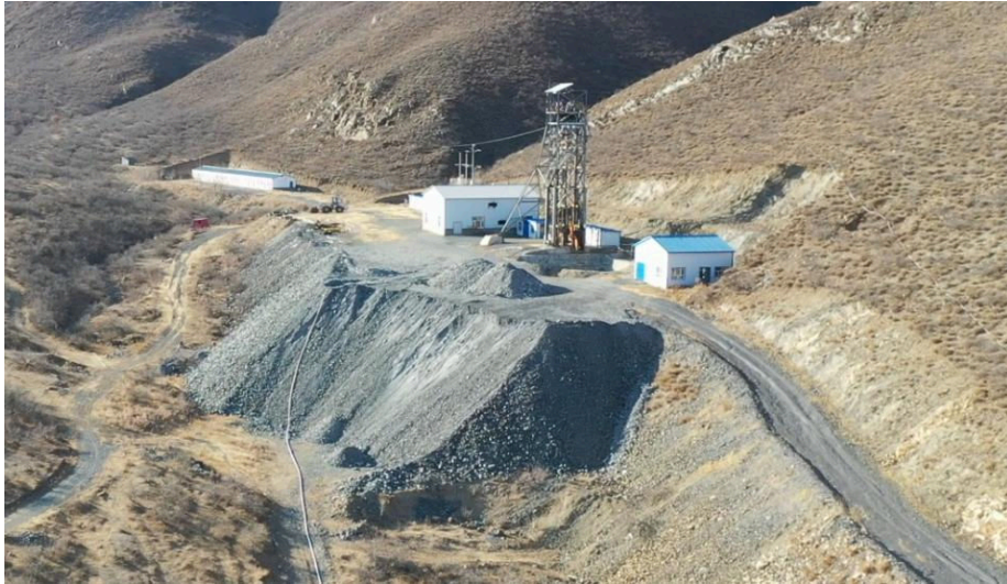
照片 1-3 风井 (FJ1) 工业场地
