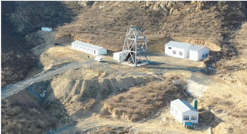
照片 1-2 竖井（SJ1）工业场地
