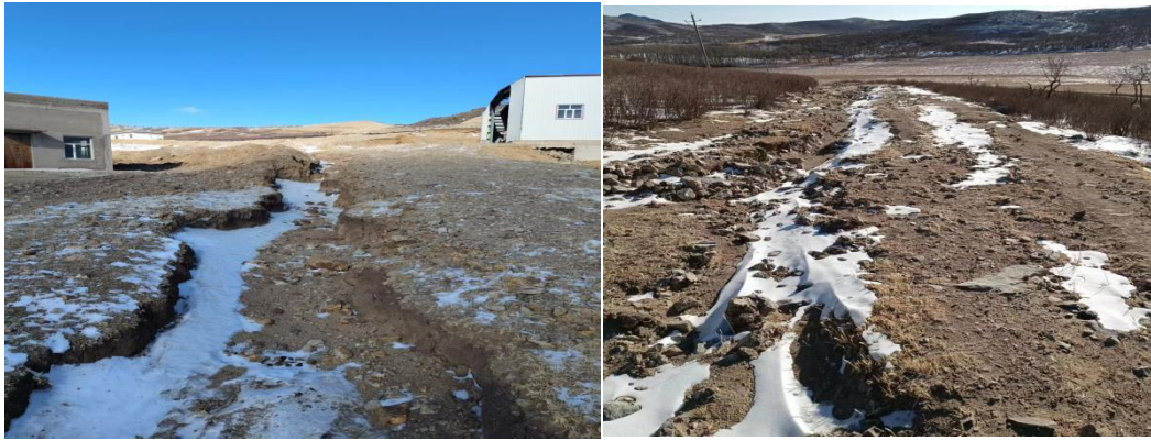
照片 4-8 矿区道路
