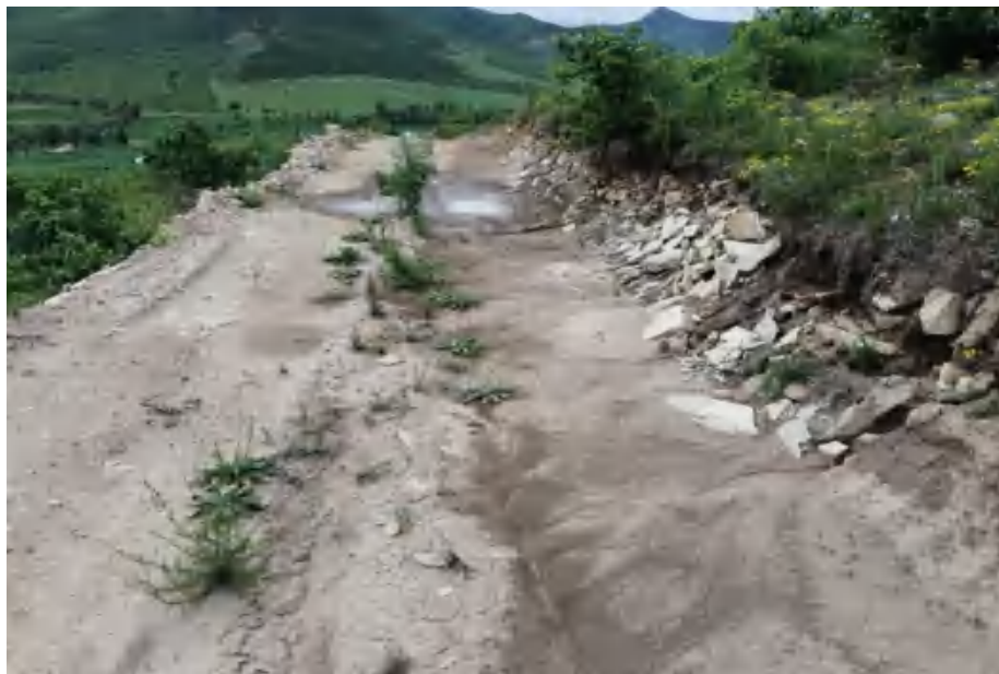
照片1-4 矿区道路
