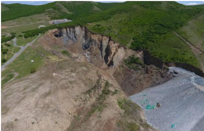
照片 3-7 现状塌陷坑（已部分回填）
