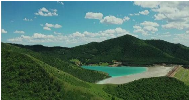
照片 3-3 尾矿库照片
