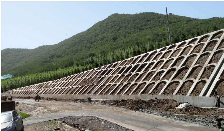
照片 4-4 风井工业场地北侧边坡的规整取值、整形、框格护坡
