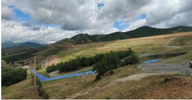
照片 3-4 尾矿坝照片
