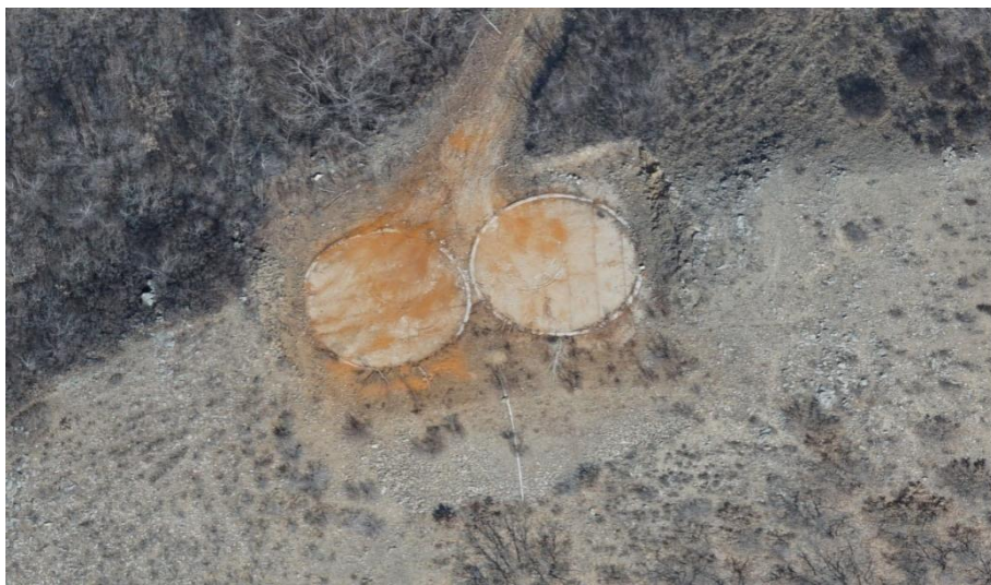
照片 3-9 高位水池
