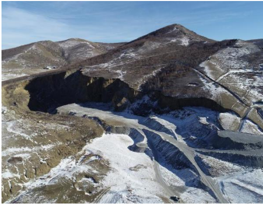
照片 6-1 现状塌陷坑
