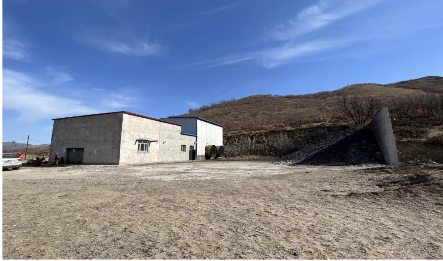
照片 3-6 回风井工业区
