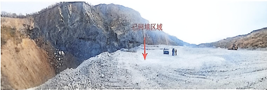
照片 1 现状塌陷坑（回填）治理效果
