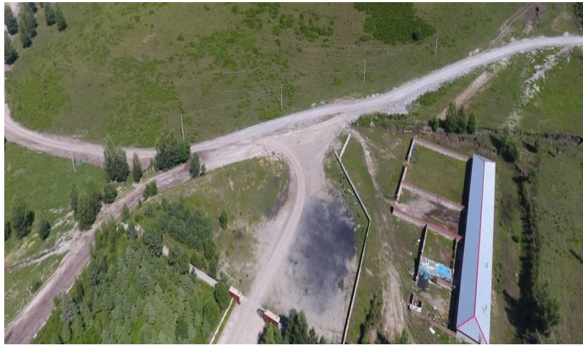
照片 3-7 矿区道路
