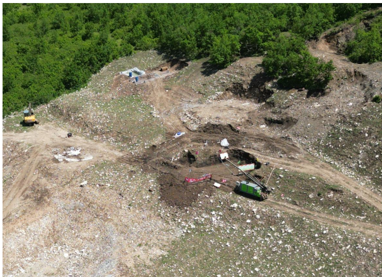
照片 3-5 钻机平台
