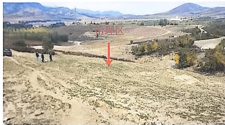
照片 1 和普矿废石场（石方清运、覆土、种草）治理效果
