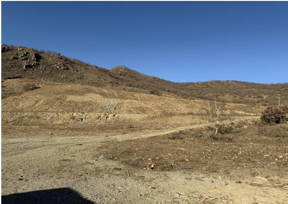
照片 3-2-1 副井工业场地（坡面存在水蚀冲沟现象）
