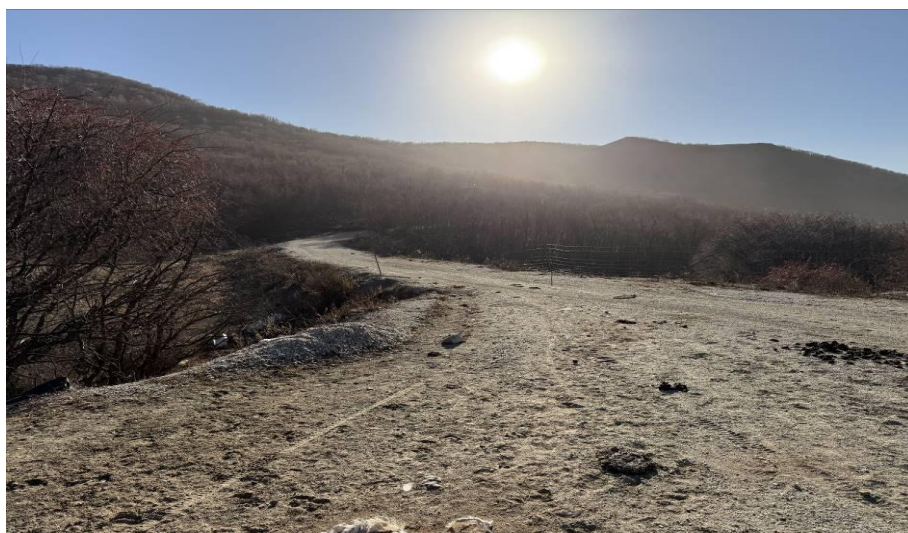
照片 3-5 矿区道路
