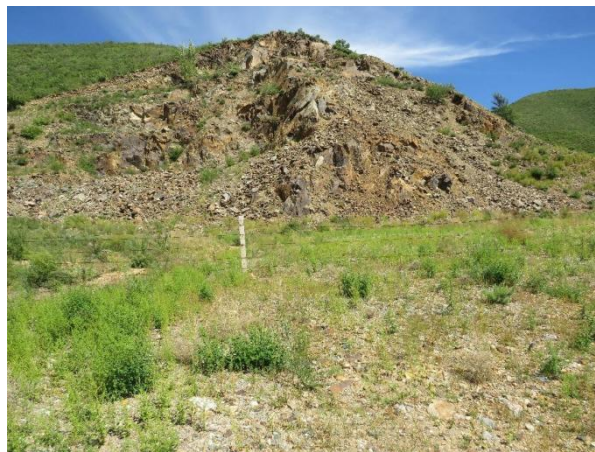
照片 1-2 2#露天采坑
