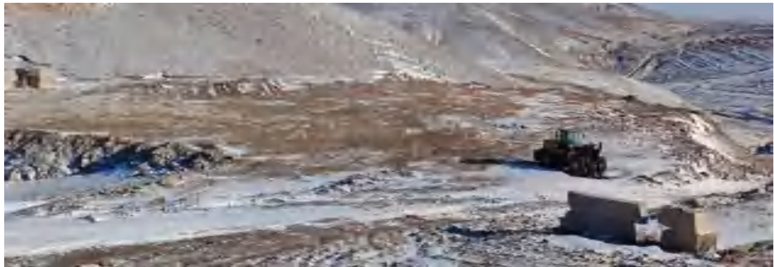
照片 1-2-2 废石堆 1 顶部
