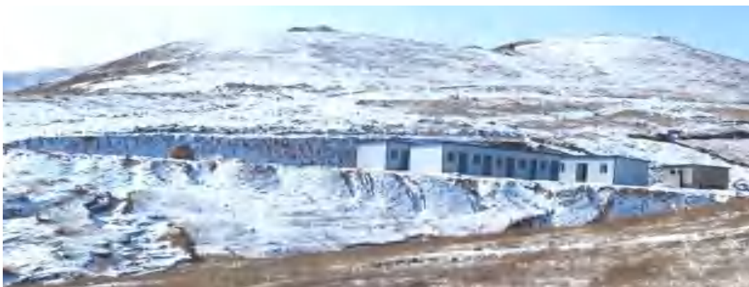
照片 1-4 临时生活区
