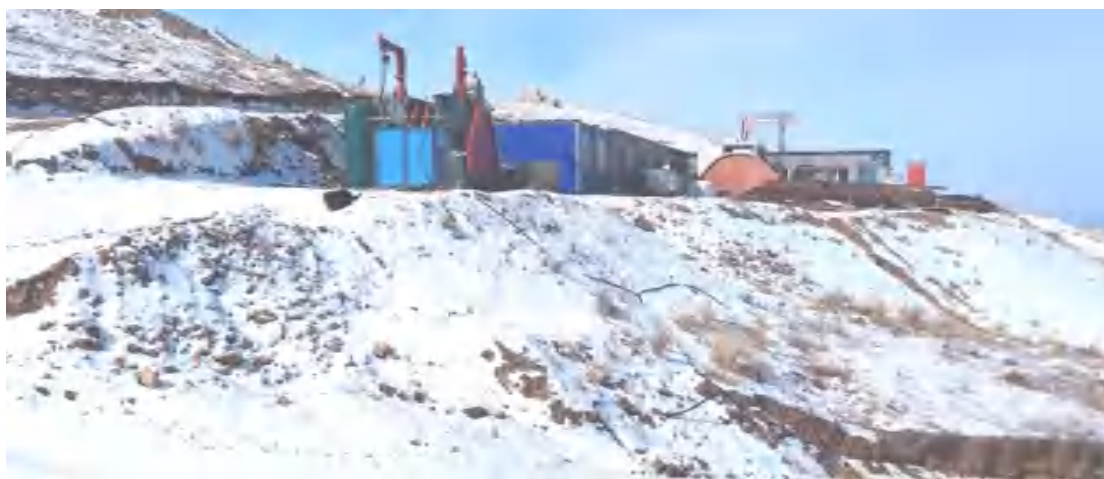
照片1-3 临时办公区
