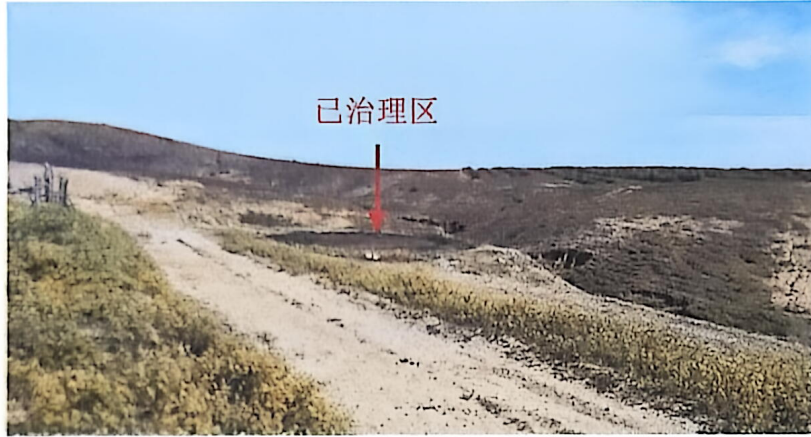
照片 1 办公生活区（拆除、清运）治理效果
