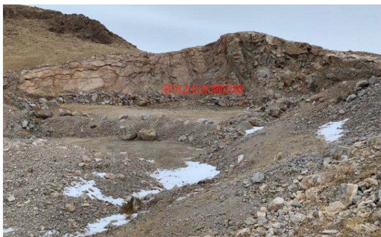
照片 1-3 采坑 2 北东侧边坡
