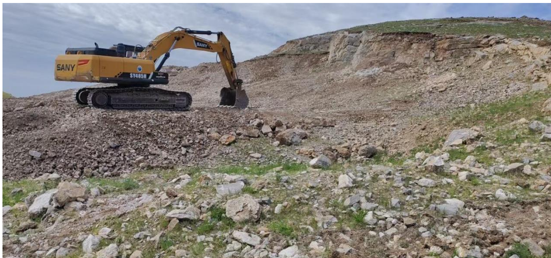
照片1-10 办公生活区（建筑物已拆除清理）
