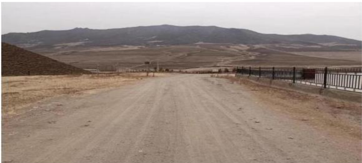
照片2-11 矿区道路
