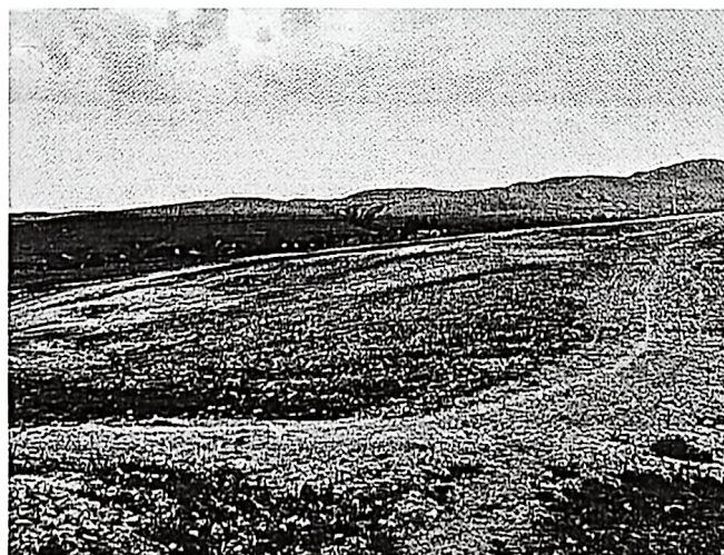
挖损区进行回填整平
