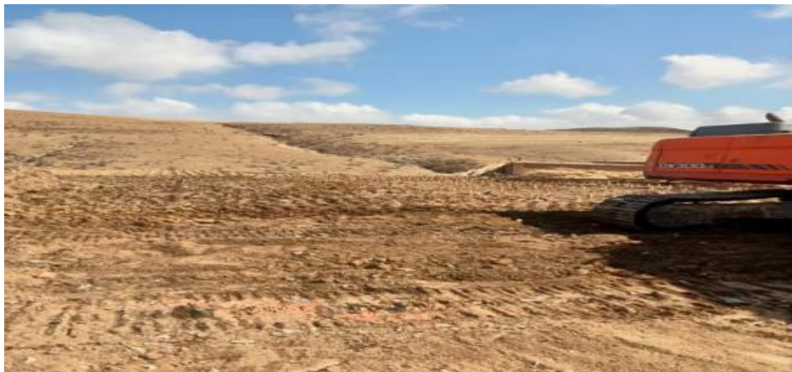
照片2-22 炸药库内的废弃房屋治理效果
