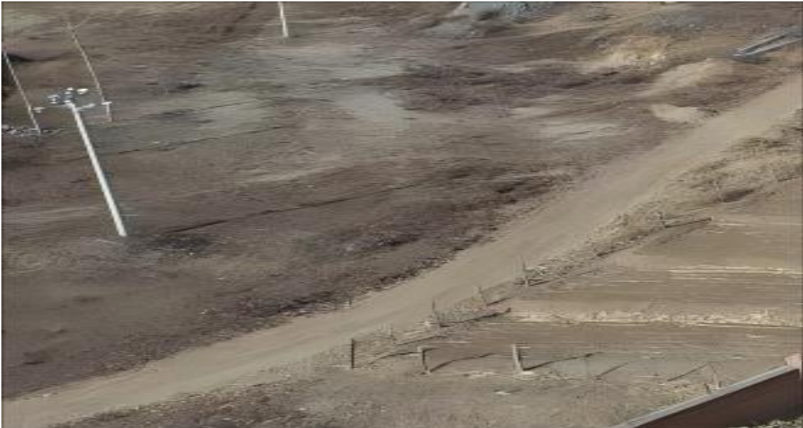
照片 2-14 矿区道路
