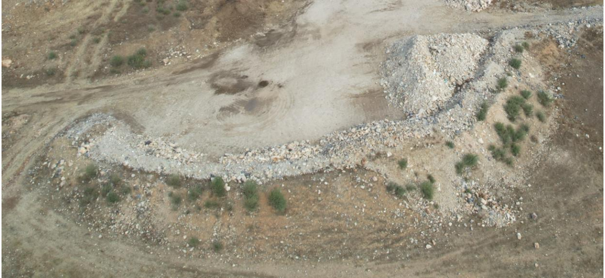
照片 1-13 II-废石场 8
