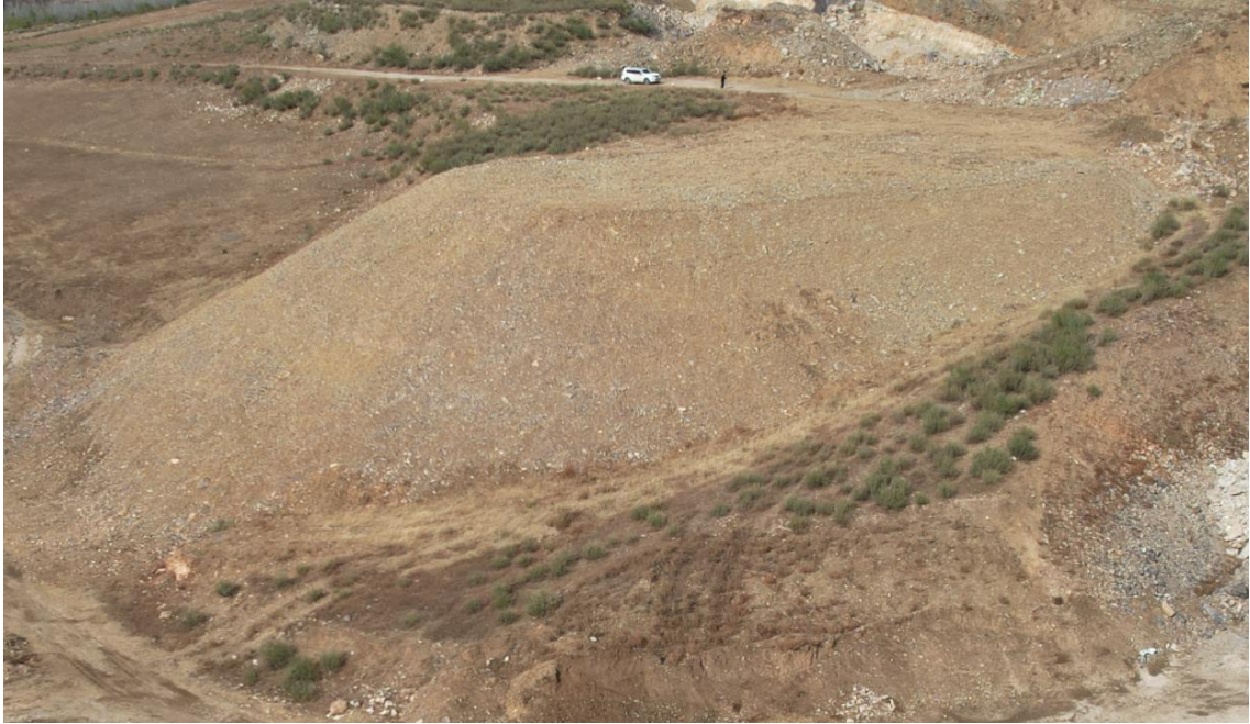
照片 1-15 II-废石场 10
