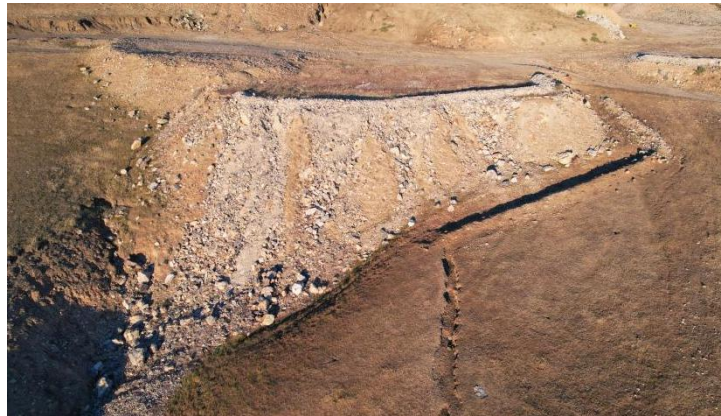
照片1-12 II-废石场2
