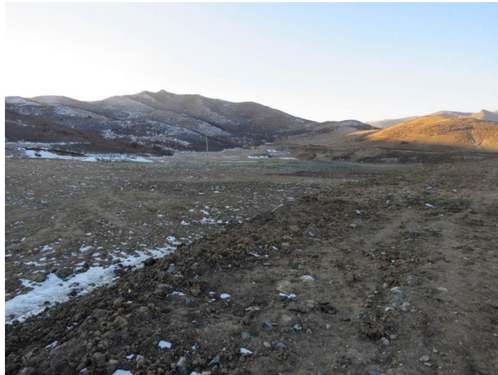
照片1-20 矿山完成平整、覆土后的2#尾矿库
