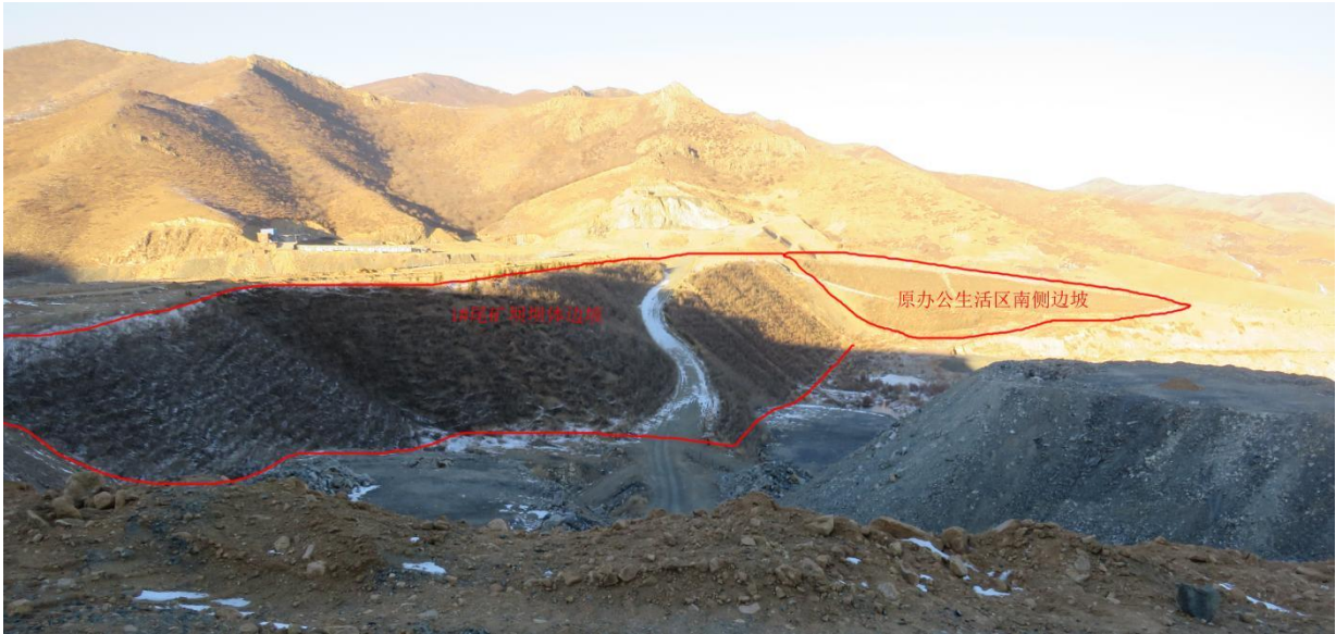
照片1-9 覆土恢复植被的1#尾矿库尾矿坝边坡和办公生活区南侧边坡
