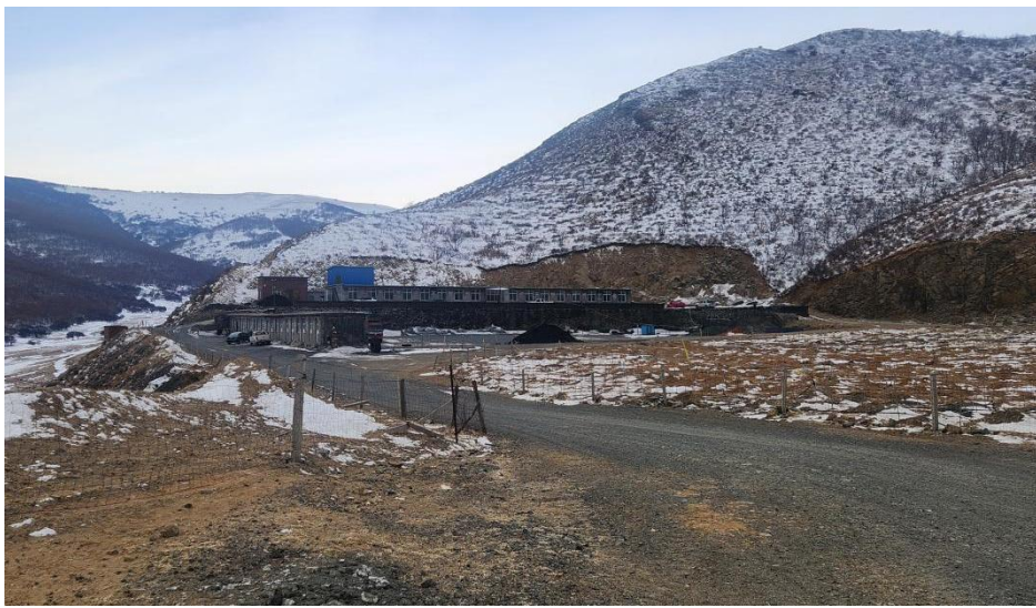
照片1-17 矿山拆除清理、覆土后的选矿车间区域
