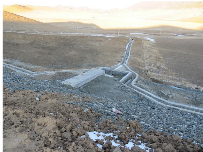
照片 1-21 2#尾矿库尾矿坝修建的导水渠
