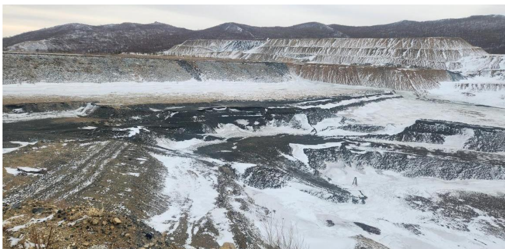
照片 1-6 1#尾矿库的尾矿坝
