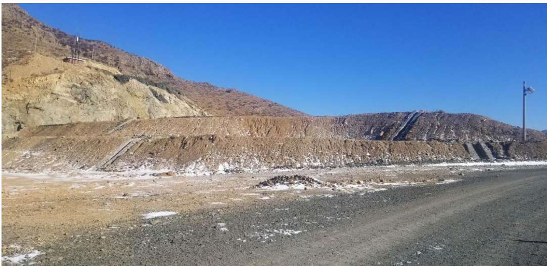
照片1-18 矿山修建台阶、导水渠的废弃选矿厂东侧的废弃料堆
