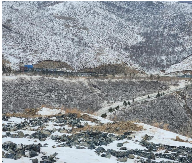
照片 1-15 覆土整平种草的 1#工业场地北侧边坡
