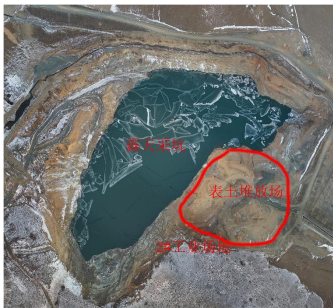
照片 1-11 矿山完成治理的 2#工业场地和用于覆土的表土堆放场
