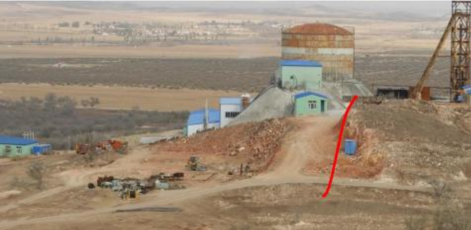
照片 1-14 切坡路段（通往 SJ1 工业场地）
