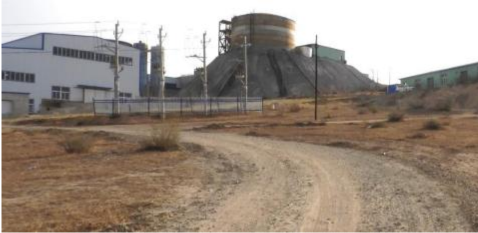
照片 1-15 矿区道路
