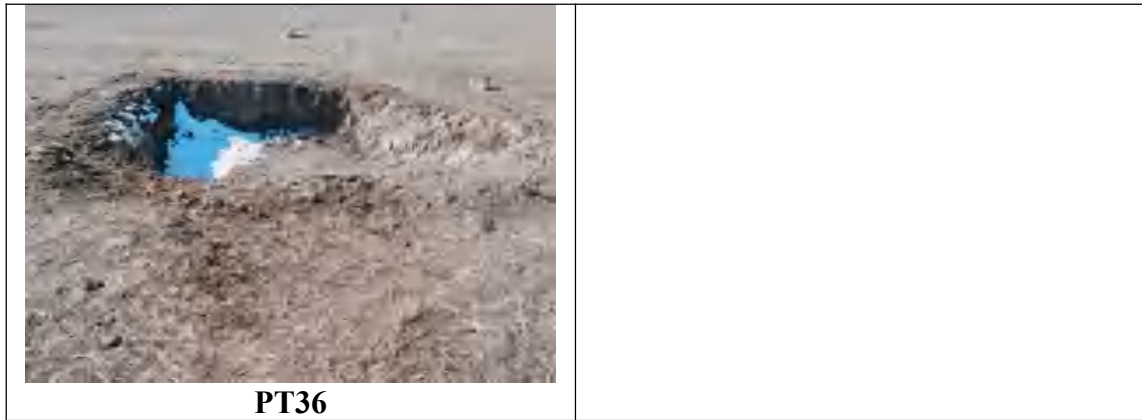
照片 3-4 钻机平台照片
