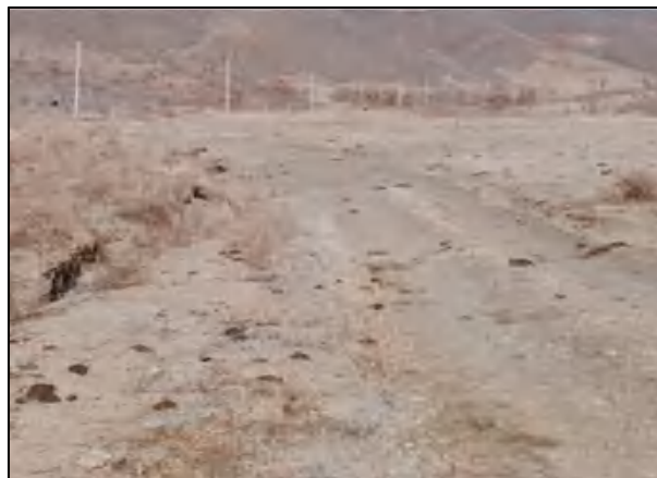
照片 3-5 矿区道路
