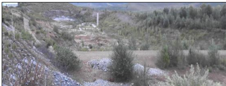
照片 4-11 尾矿库上游视角
