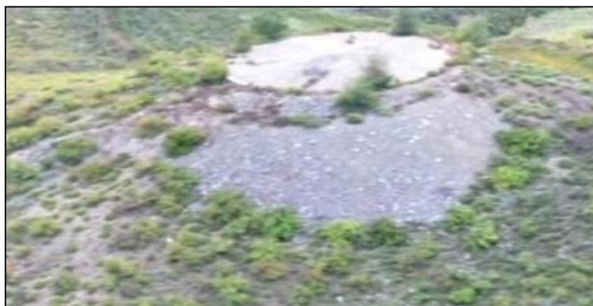
照片 4-12 高位水池
