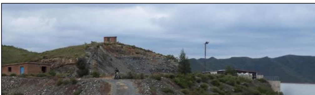
照片 4-10 选矿厂北侧切坡
