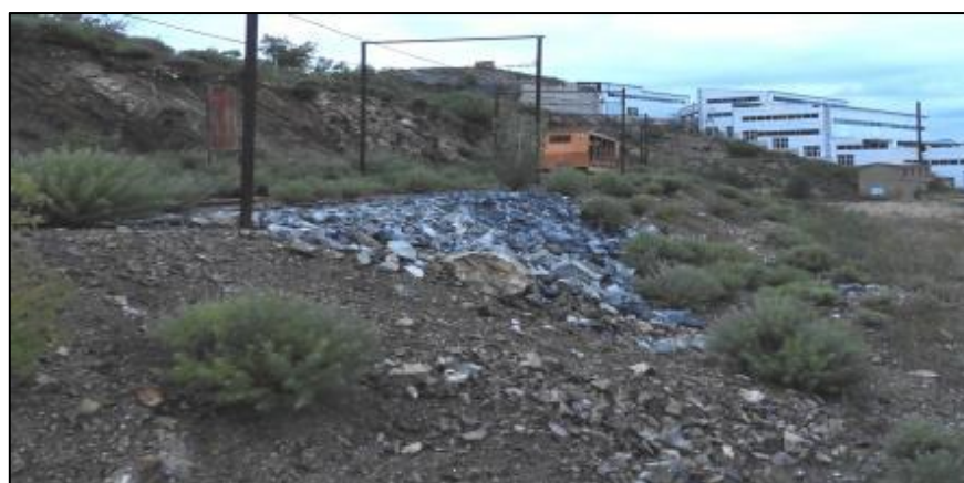
照片 4-3 PD1 工业场地东侧铺设铁轨
