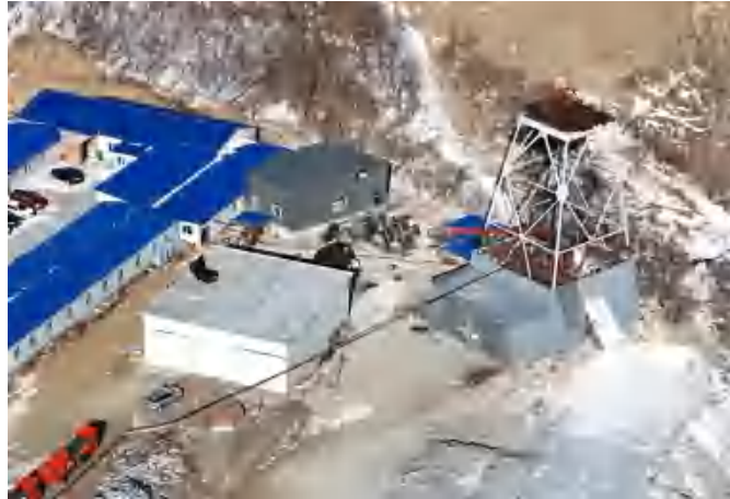
照片 4-4 探矿井工业场地
