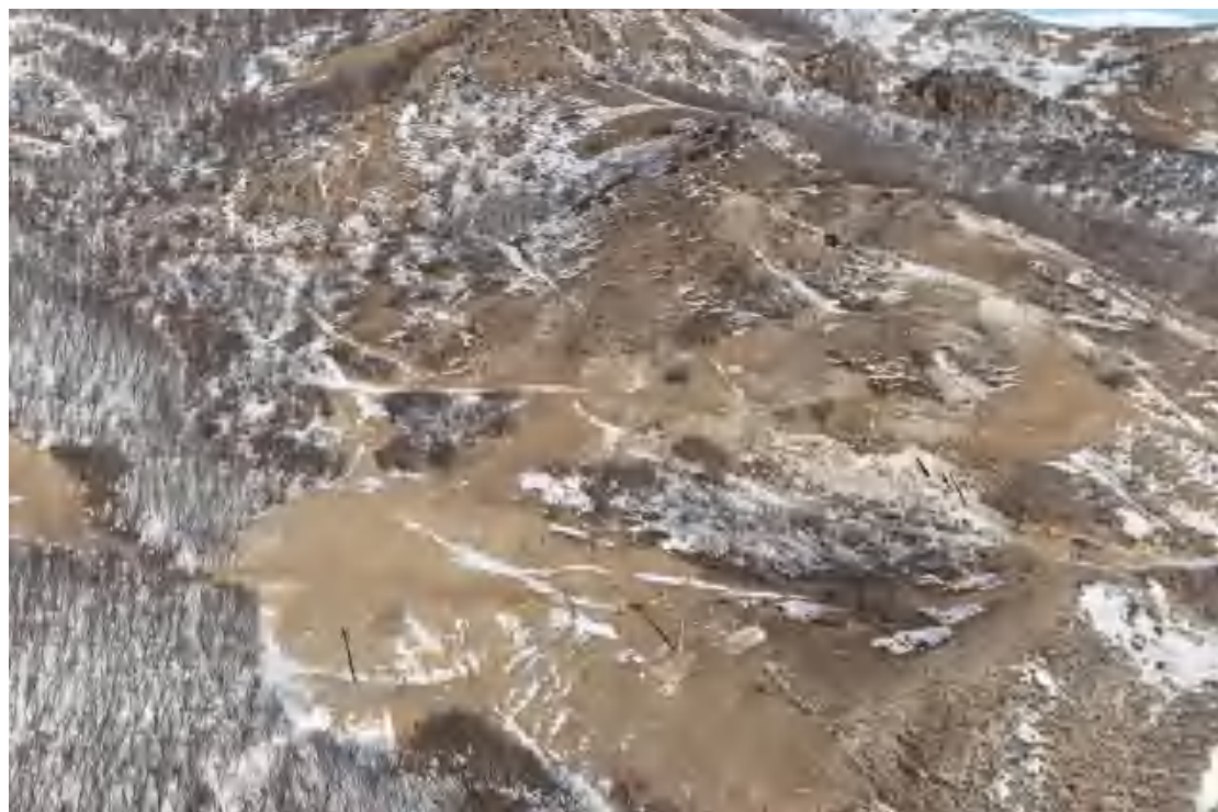
照片2-3 前期治理的3#废石场、4#废石场、5#废石场、6#废石场治理效果
