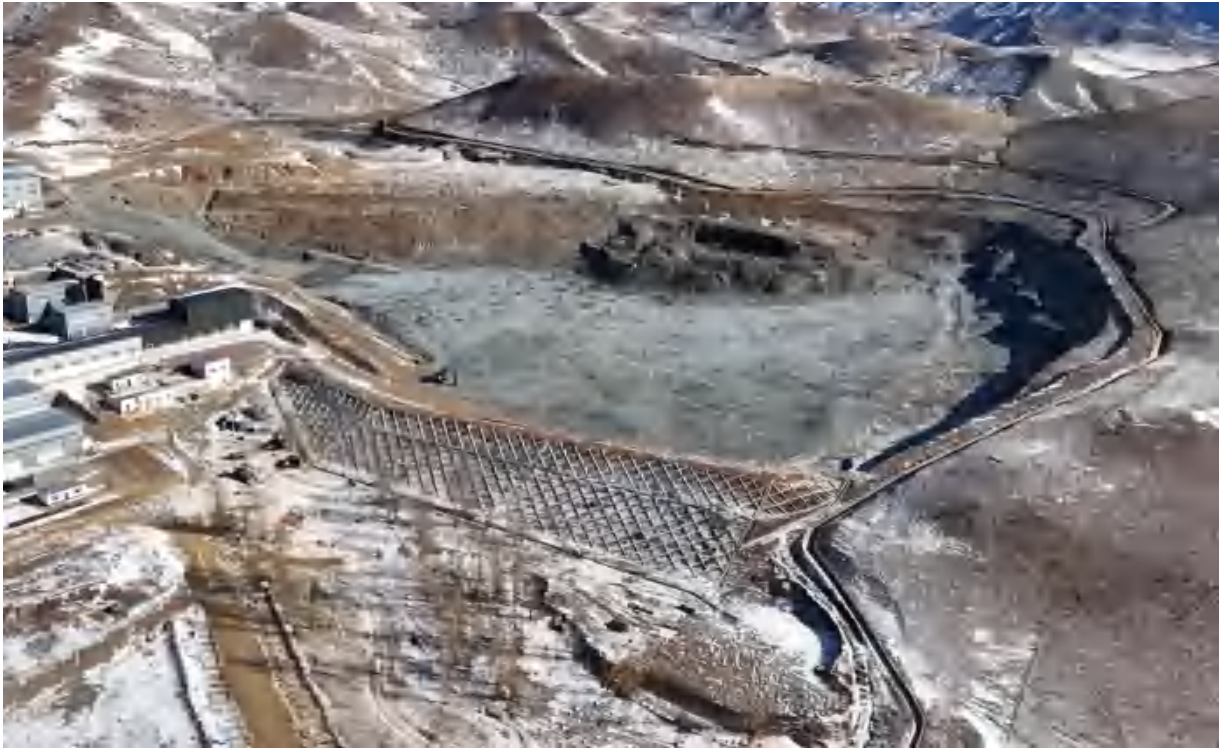
照片 4-15 二号尾矿库
