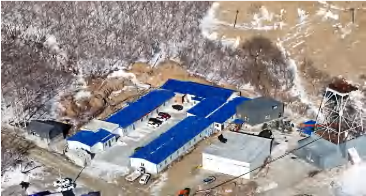
照片 4-5 斜井工业场地
