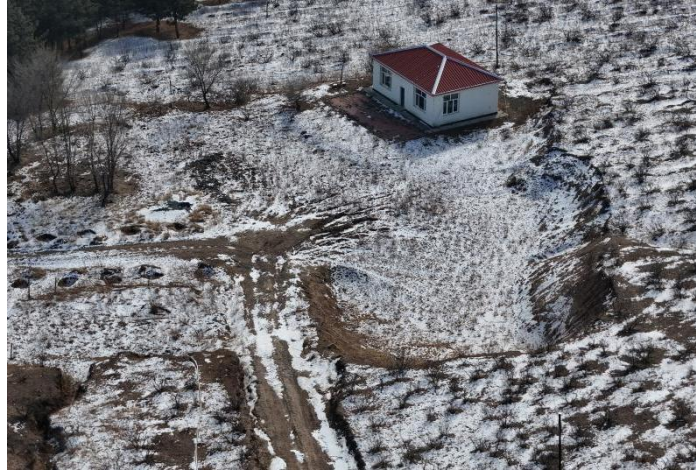
照片 2-4 值班室及前期治理的边坡
