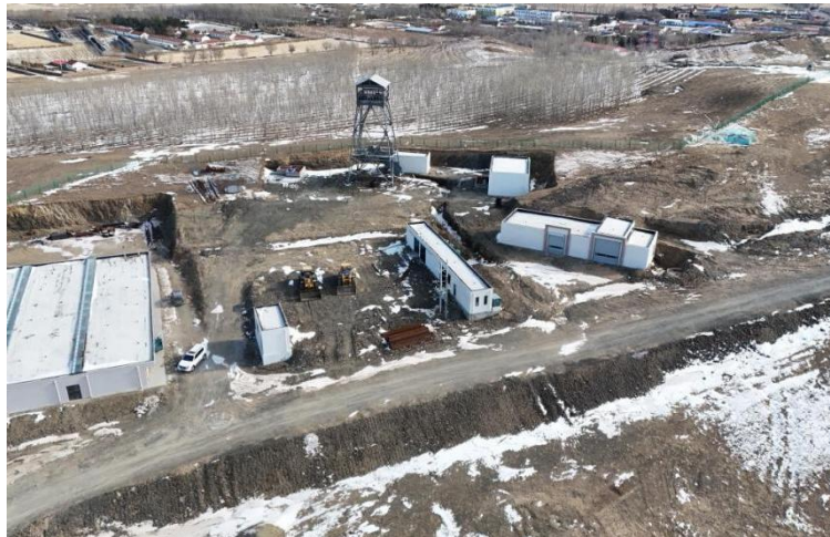
照片 2-12 新建风井工业场地
