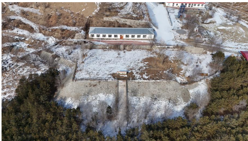
照片 2-2 办公生活区及宿舍及锅炉房治理区域
