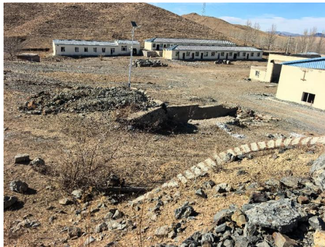
照片 2-9 选矿厂矿石堆放场遗留建筑垃圾
