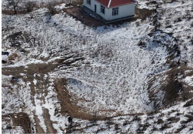
照片2-1 生活区空地及边坡治理效果
