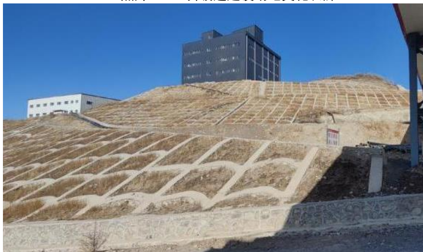
照片 4-7 充填站南侧框格护坡
