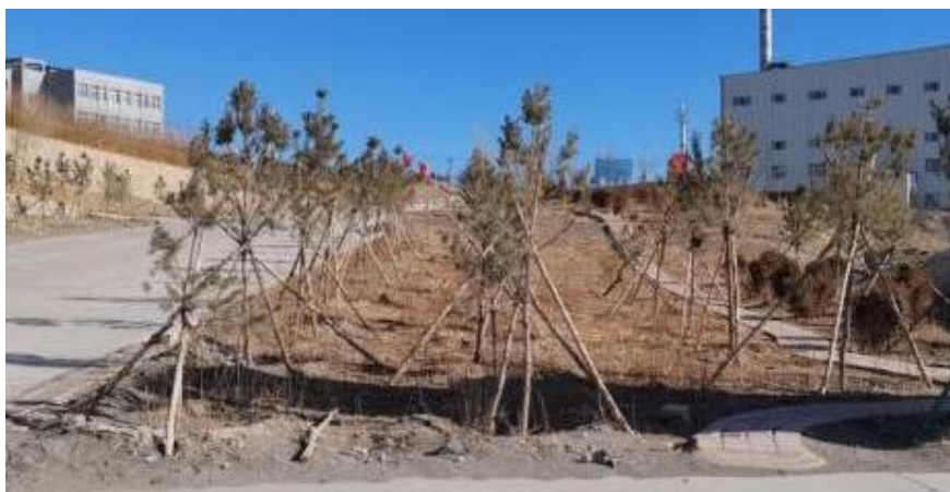
照片 4-6 斜坡道建设场地文化长廊
