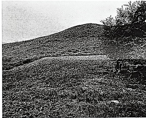
矿山完成治理的6#废石场
