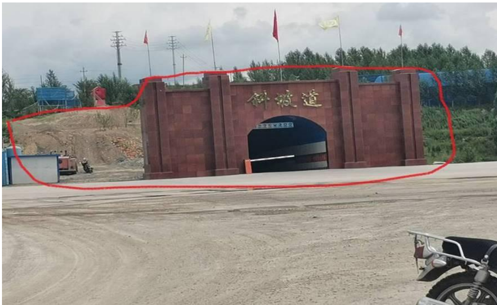
照片 3-7 斜坡道建设场地
