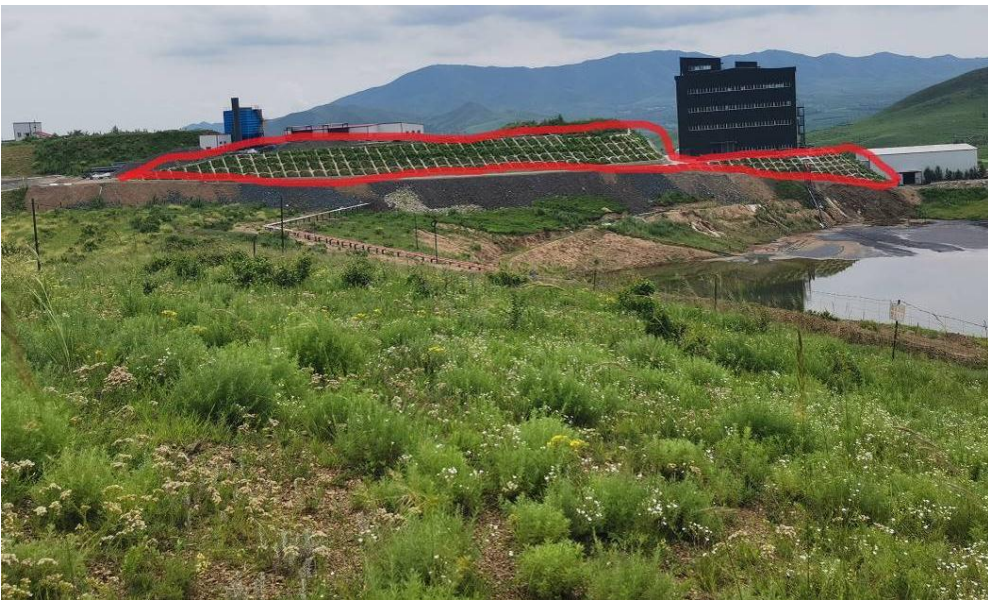
照片 4-2 矿山治理后的选矿厂西侧边坡
