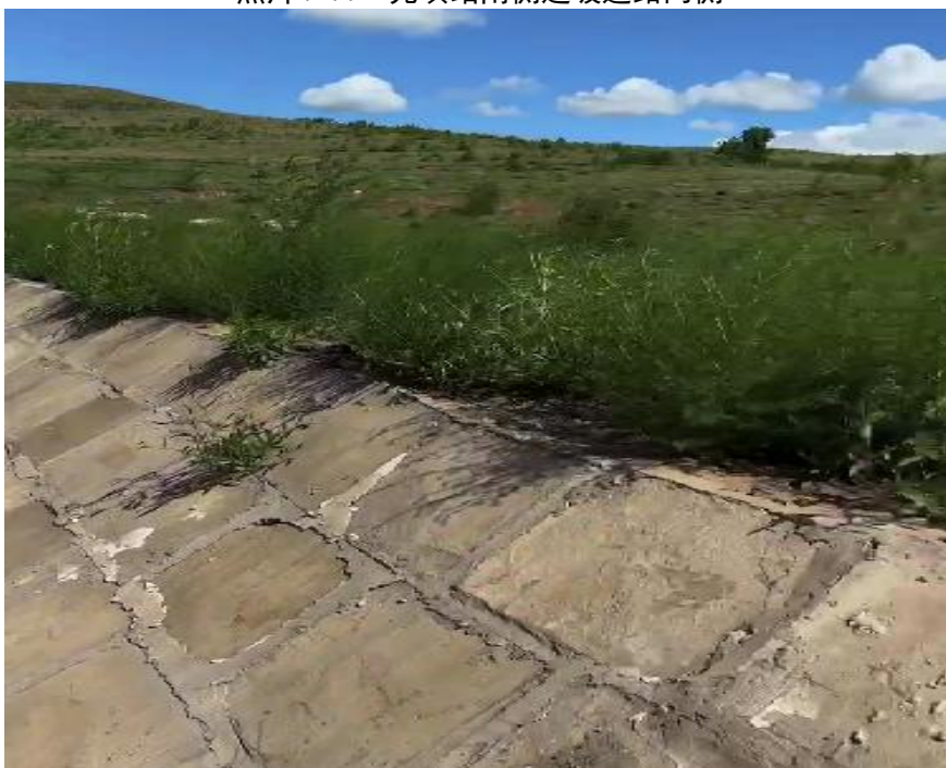
照片 4-12 新建截洪沟边坡
