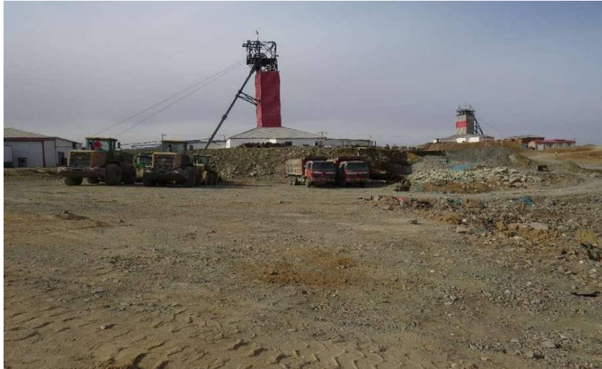
照片 3-2 1#工业场地边坡
