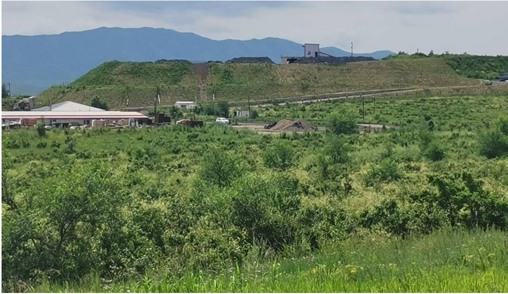
照片 4-1 矿山治理后的选矿厂北侧边坡
