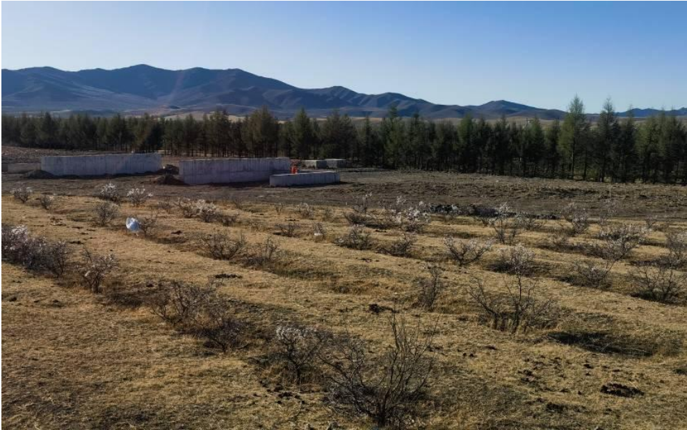
照片 3-8 进风井工业场地
