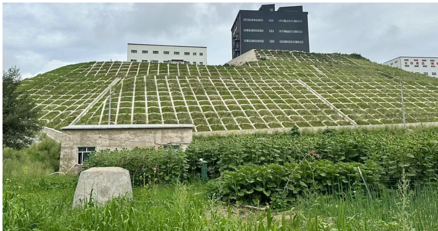
照片4-11 充填站南侧边坡道路两侧
