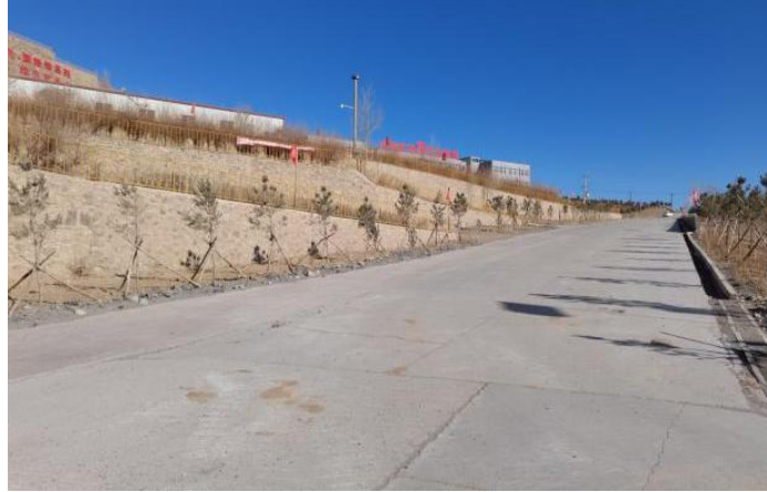
照片 3-18 矿区道路
