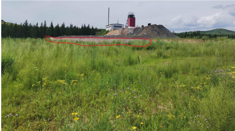
照片 4-7 矿山治理后的 4 号废石坎底处砌设挡墙
