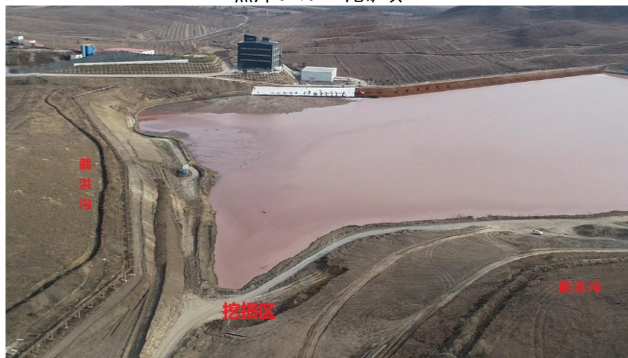
照片 3-11 尾矿库及截洪沟
