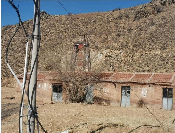
照片 4-3 3#竖井工业场地
