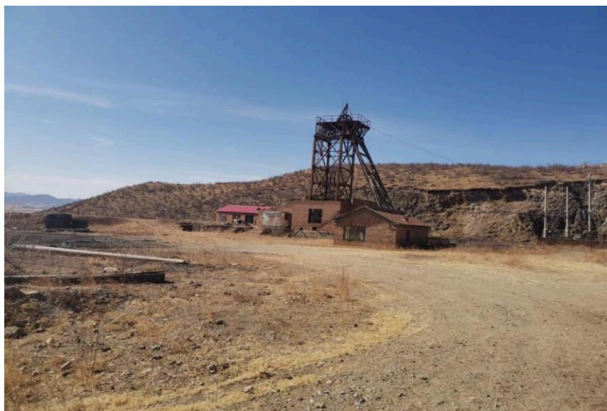
照片 4-4 4#竖井工业场地
