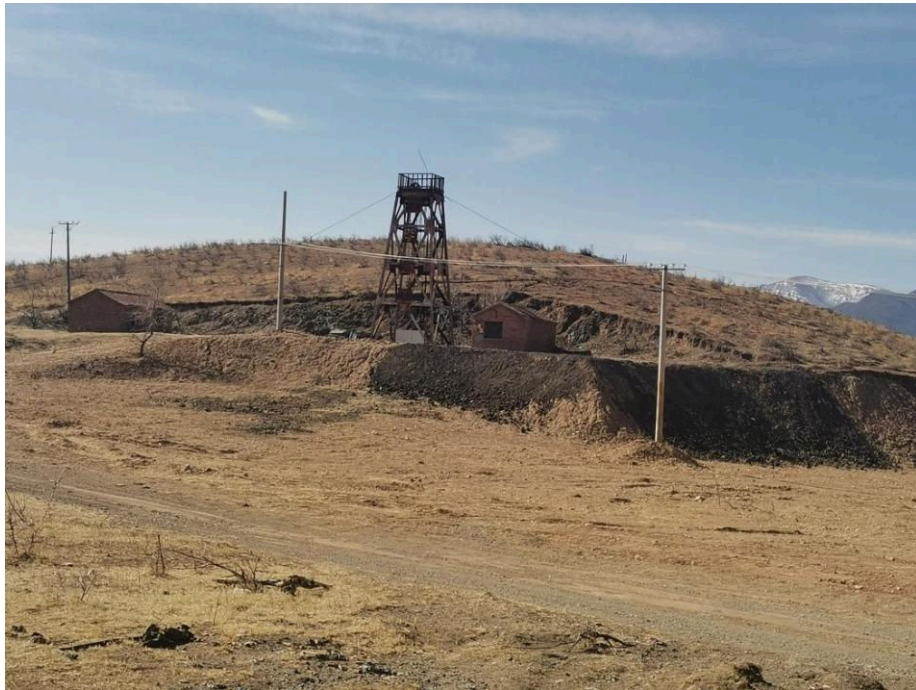
照片 4-2 2#竖井工业场地
