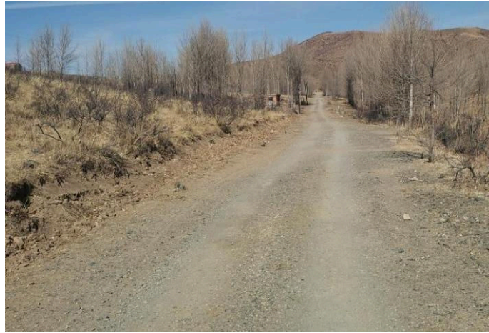
照片 4-10 矿区道路
