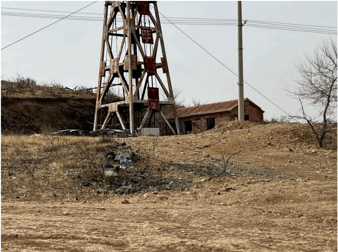
照片 4-1 1#竖井工业场地
