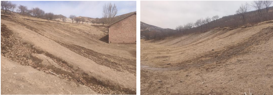
照片 4-3 已治理办公生活区切坡
