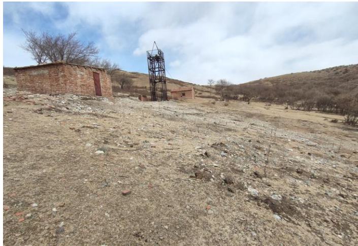
照片 4-8 SJ3 工业场地治理区切坡治理
