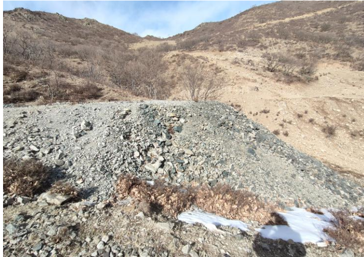
照片 4-9 4 号废石场边坡整形治理
