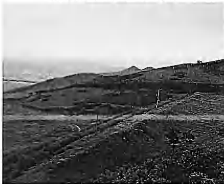
矿山完善治理的尾矿库东侧切坡
