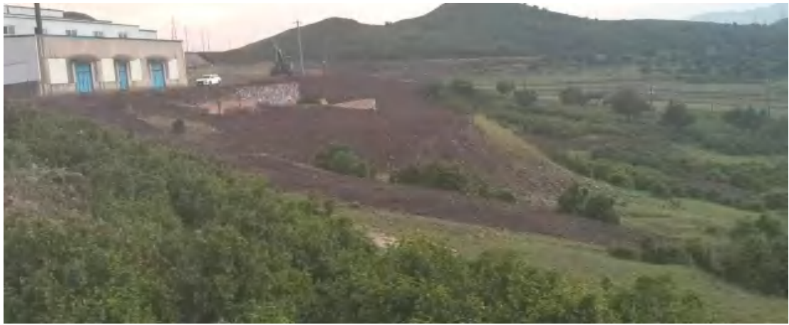
照片1-10 选矿厂前缘堆坡（2025年治理场地）
