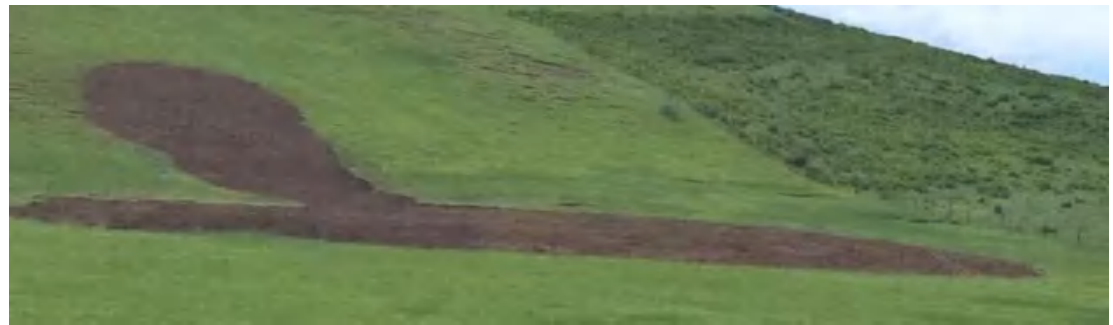
照片1-11 探坑2（2025年治理场地）
