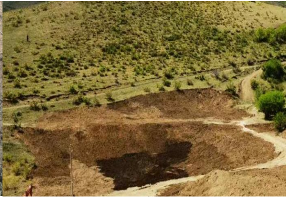
照片1-25 探坑1及废石堆治理效果
