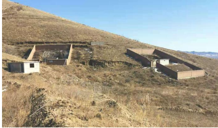
照片 1-16 炸药库和雷管库
