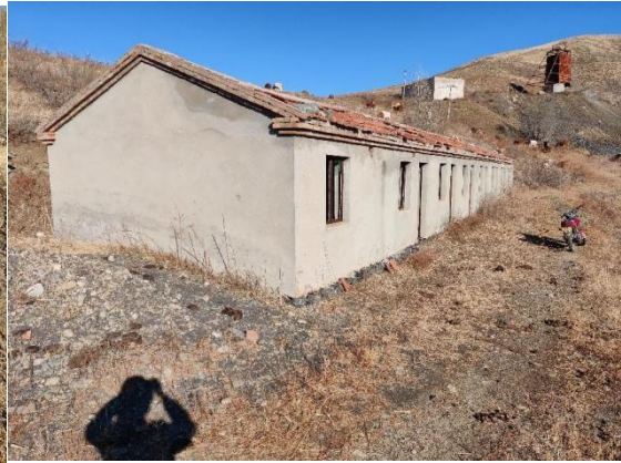
照片 1-4 PD1 场地内建筑物
