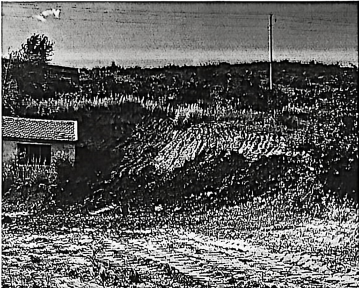
矿山完成治理的办公生活区 1 北侧切坡
