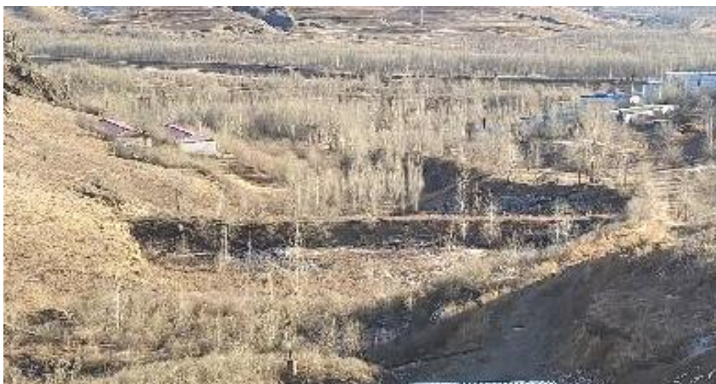
照片 1-13 尾矿库子库
