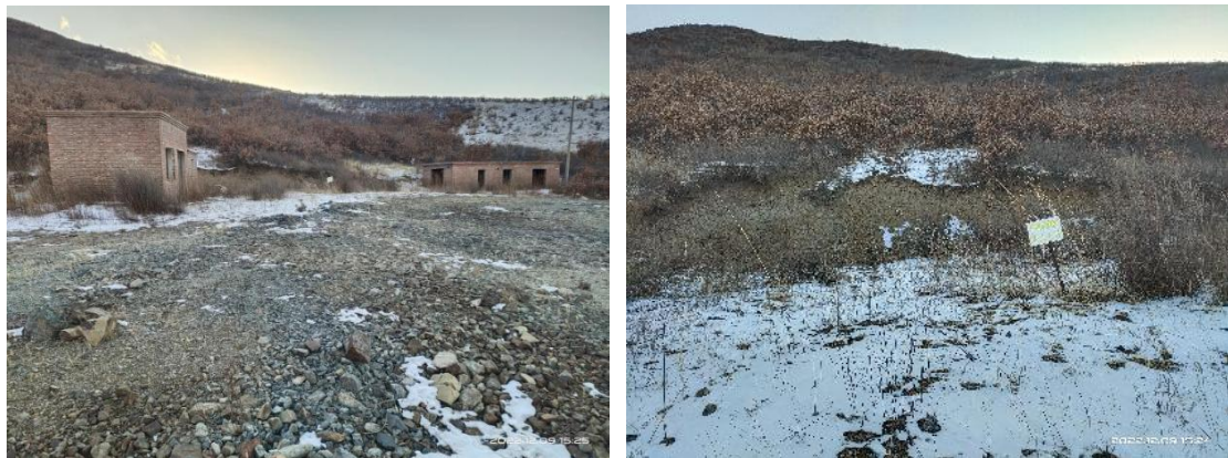
照片 1-1 SJ1 工业场地及切坡
