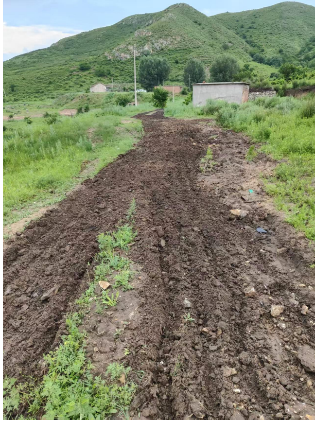
照片 1-9 矿区道路治理区域
