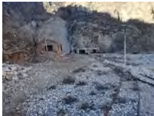
照片1-4 PD3场地内建筑物
