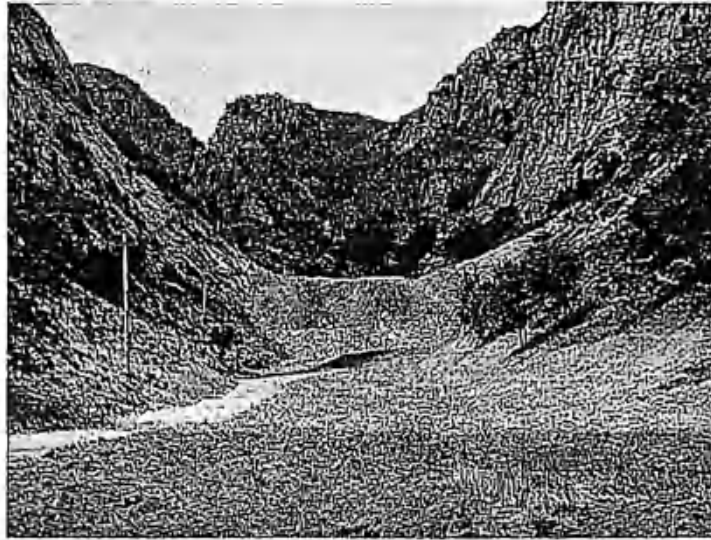
矿山完成降坡整形治理的 PD2 场地废石堆
