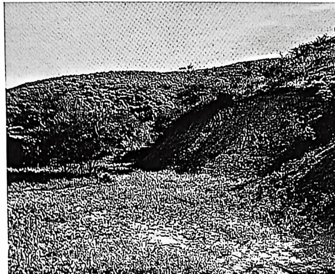
矿山完成治理的 PD3 和平硐废石场
