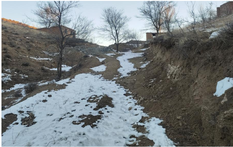
照片 1-9 矿区道路切坡路段
