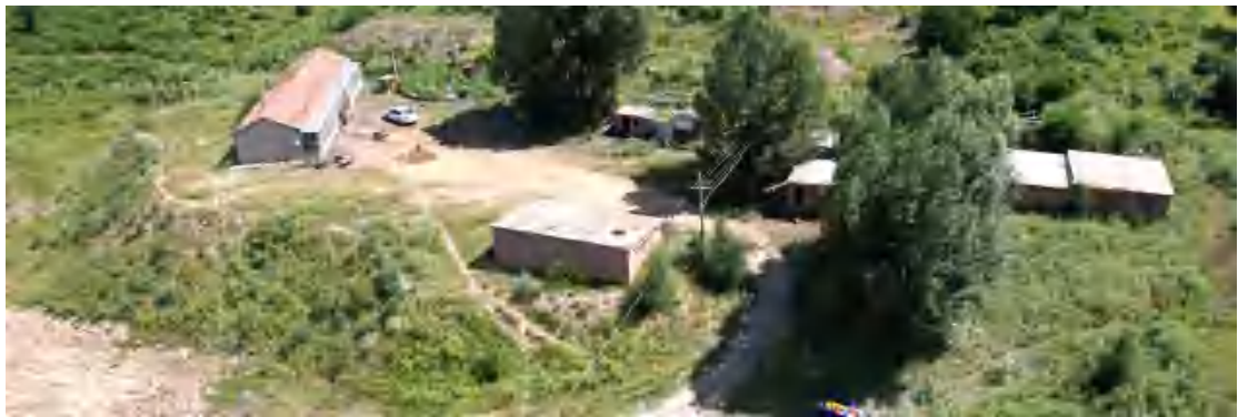
斜井工业场地（西侧视角）
