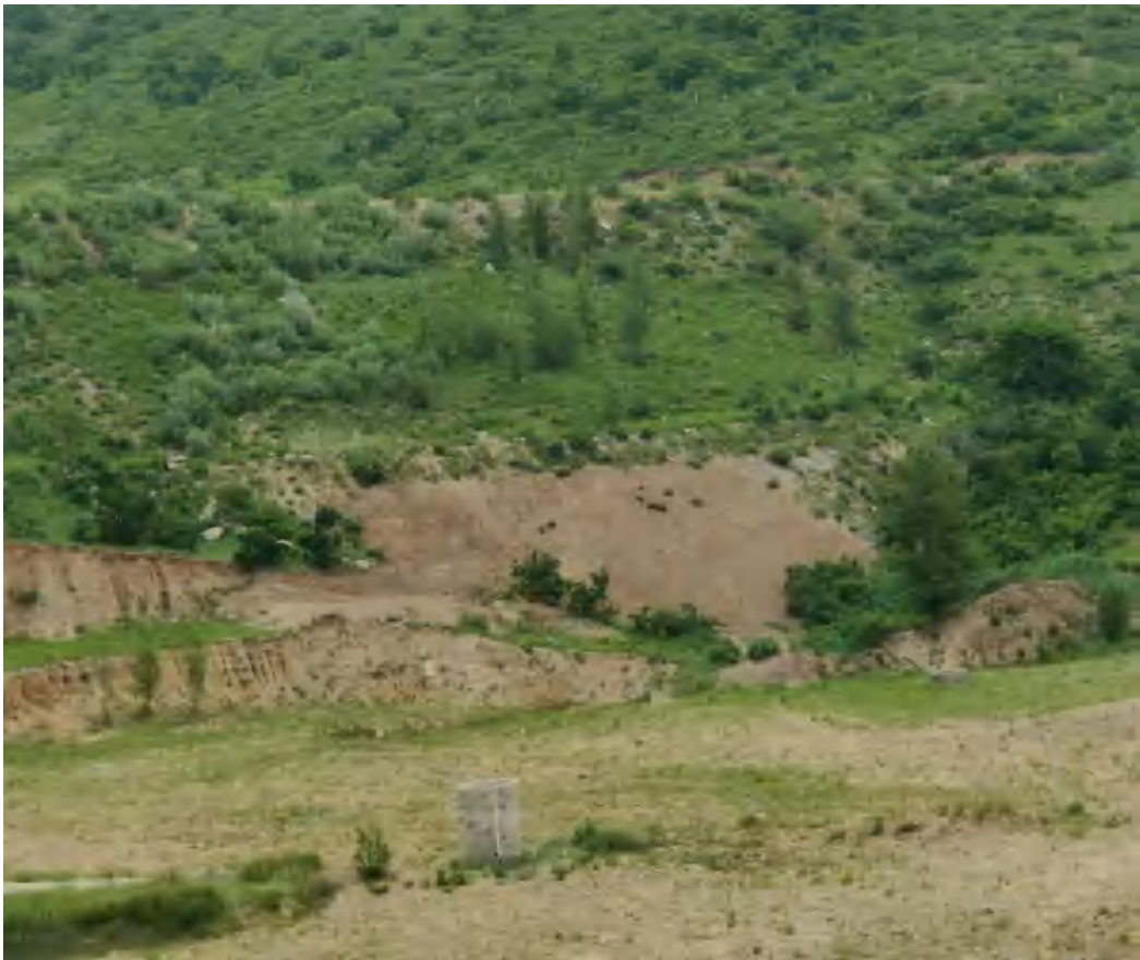
照片1-19 拦洪坝（现状已纳入尾矿库）过渡治理效果
