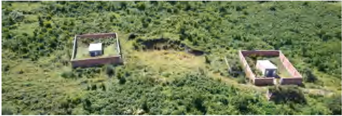
炸药库、雷管室
