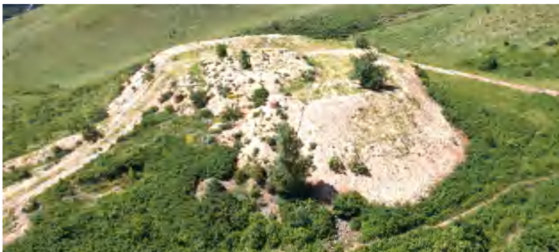
照片 1-11 高位水池
