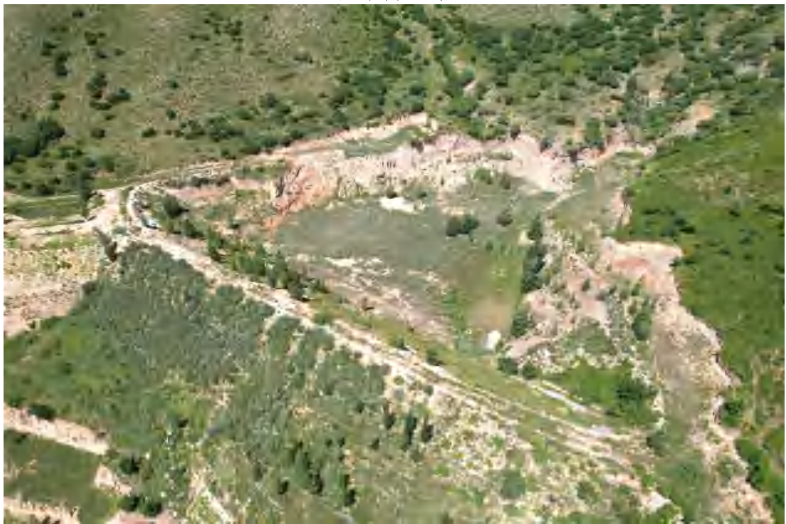
尾矿库截洪坝近景
