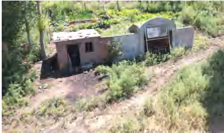
斜井井口 照片 1-3 斜井工业场地
