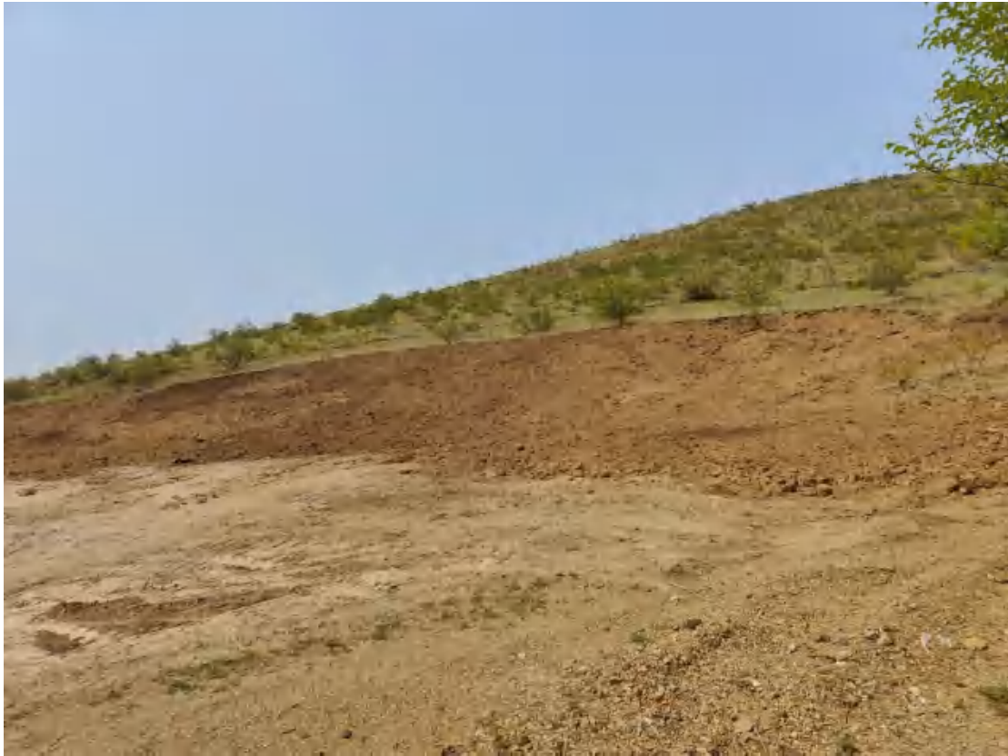
照片1-20 完善前期治理单元：采坑1治理效果
