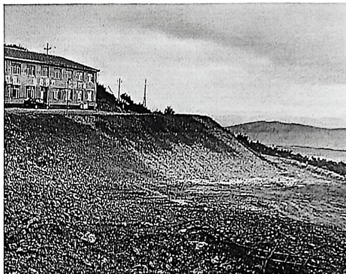
矿山完成治理的平硐废石场
