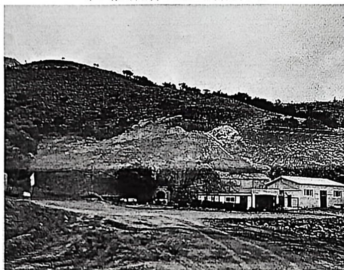
矿山完善治理的平硐工业场地北部边坡
