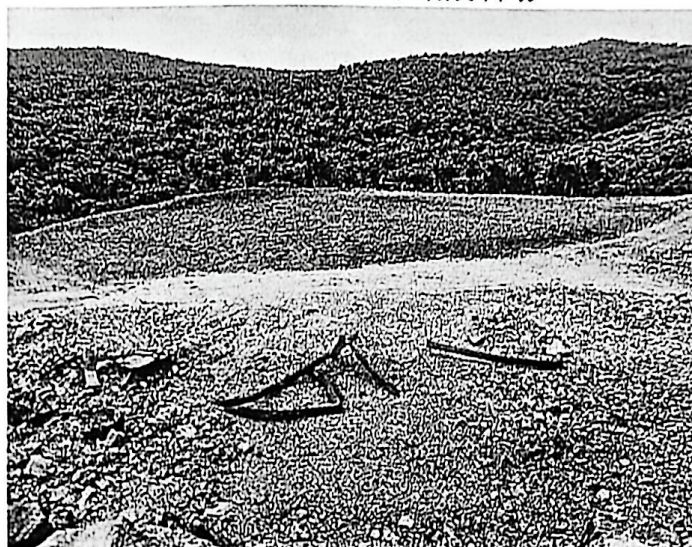
矿山完成治理的竖井废石场
