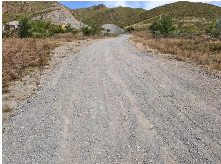
照片 2-8 矿区道路
