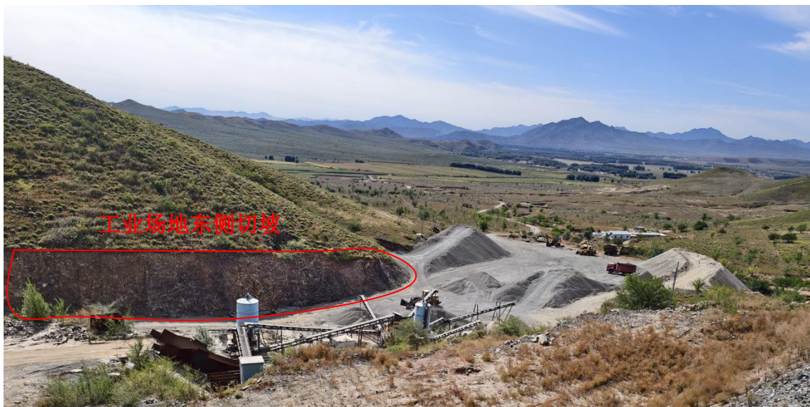
照片 2-4 工业场地切坡
