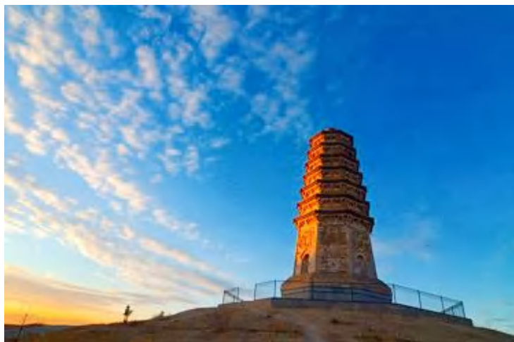
图 4-10 南塔完成保护工程
