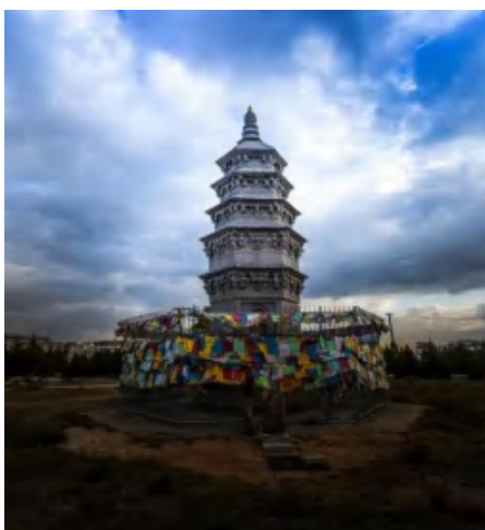
图 4-9 北塔完成保护工程
