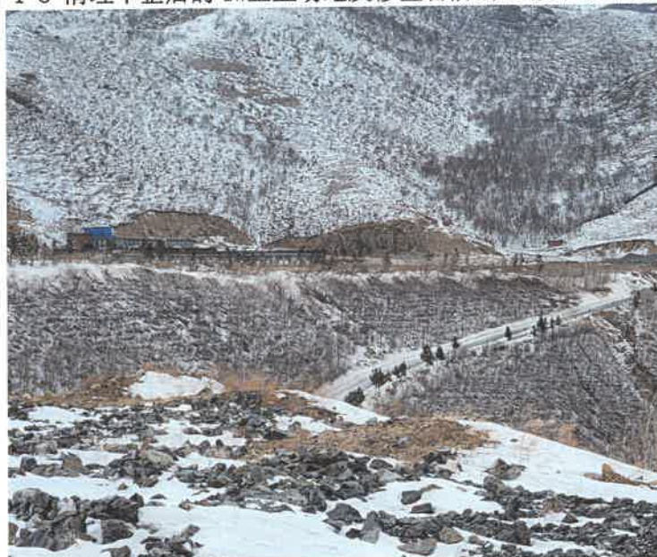
照片 1-9 覆土整平种草的 1#工业场地北侧边坡
