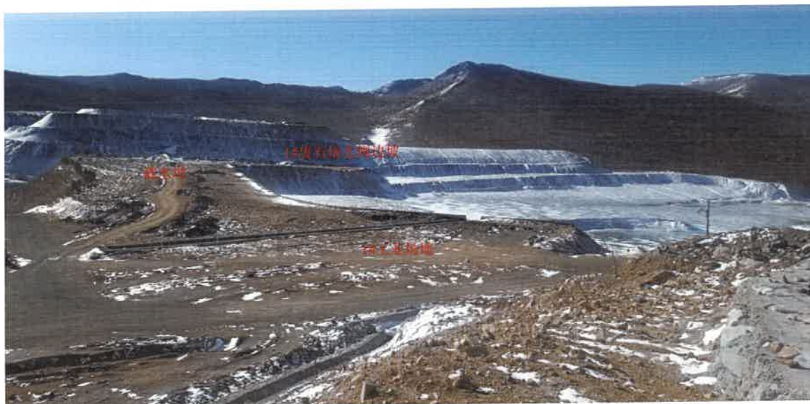
照片 1-8 清理平整后的 1#工业场地及修整台阶的 1#废石场北侧边坡
