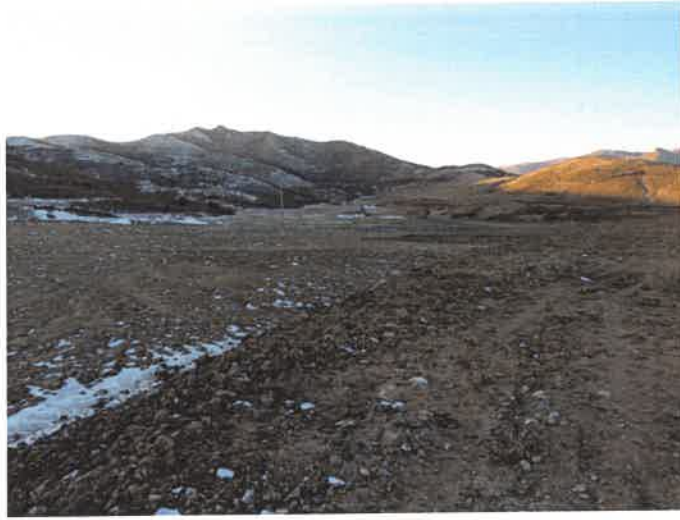
照片1-14 矿山完成平整、覆土后的2#尾矿库
