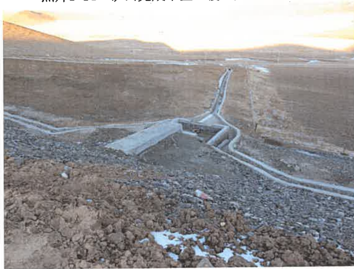
照片1-15 2#尾矿库尾矿坝修建的导水渠
