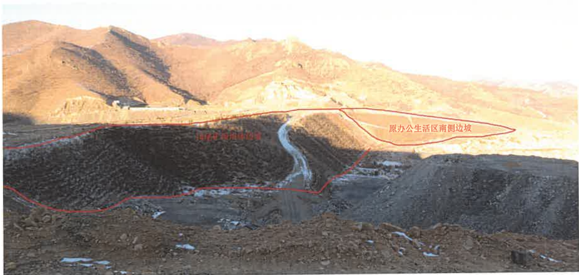
照片1-3 覆土恢复植被的1#尾矿库尾矿坝边坡和办公生活区南侧边坡
