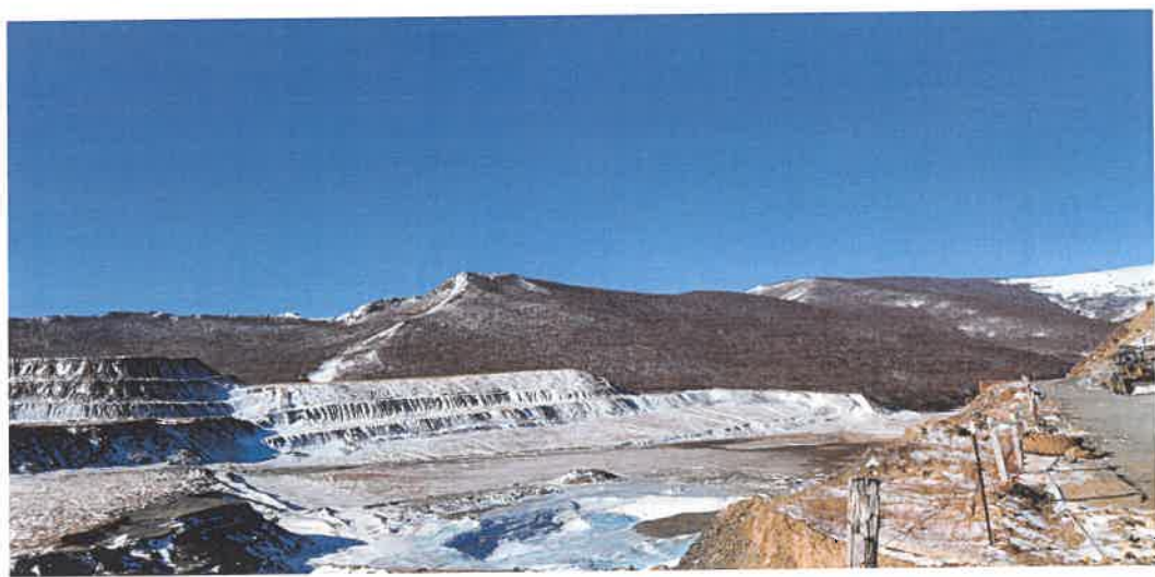
照片 4-10 1#尾矿库库区
