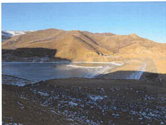
图1-10 矿山前期完成治理的1#尾矿库
