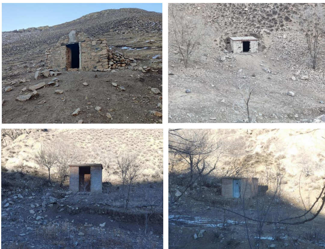
照片 4-13 废弃建筑物
