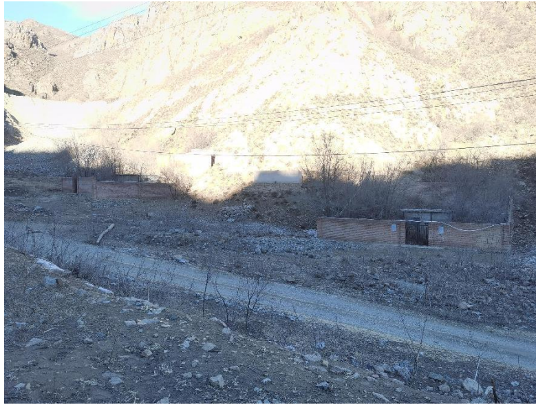
照片 4-7 雷管库和炸药库
